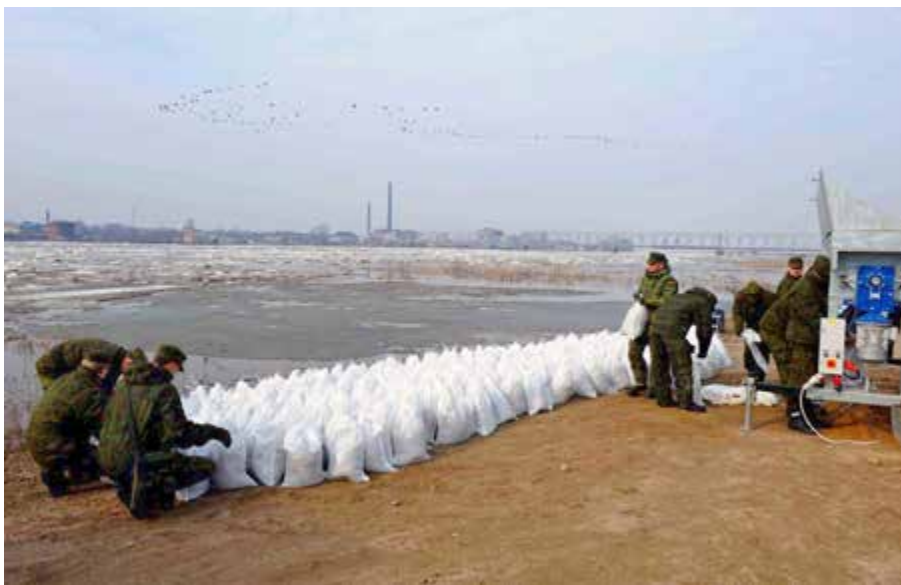
2010 m. Bataliono kariai stato apsauginius pylimus potvynio Šilutėje metu. PJVIB nuotr.
